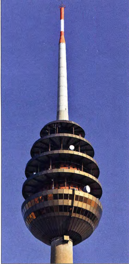
Bild 3: Turmkorb und Antennenmast des Fernmeldeturms Nürnberg
